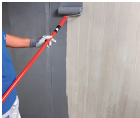
Applicazione di Eco Prim Grip Plus a rullo su supporto in calcestruzzo
