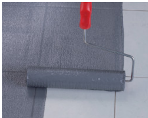
Applicazione a rullo di Eco Prim Grip Plus su pavimento preesistente in piastrelle di gres porcellanato
